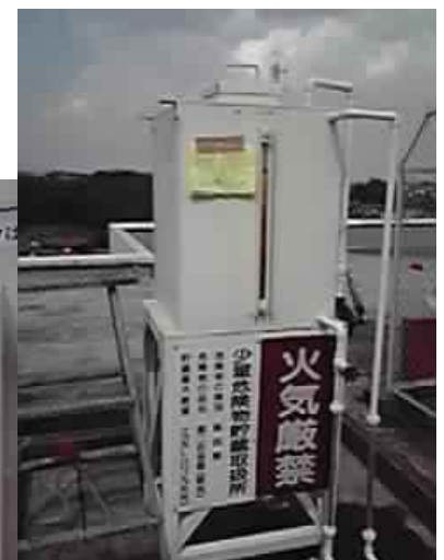
屋上にある非常用電源のための軽油タンク(右)と使用量を をチェックする用紙(中央)、補充用ポリタンク・缶(左)
